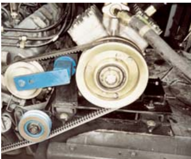
Tensor de correa en compresor
